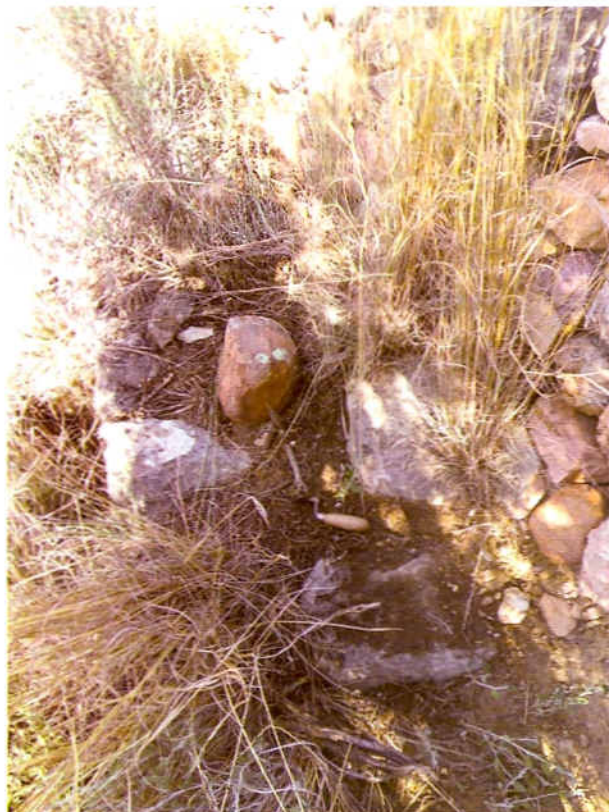
Figura 4. Cimientos de muros localizados en la cima de la colina.
