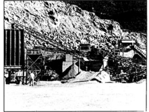
Los trabajos en la cantera han sido ampliados
